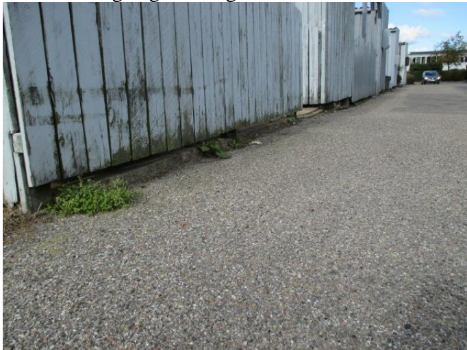
Foto 2. Belægningssten i gården over nuværende asfalteniveau
